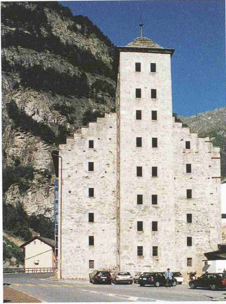
Der Stockalperturm in Gondo VS: nach der Instandstellung mit Sälen, Museum und Café (Bild: SHS)
