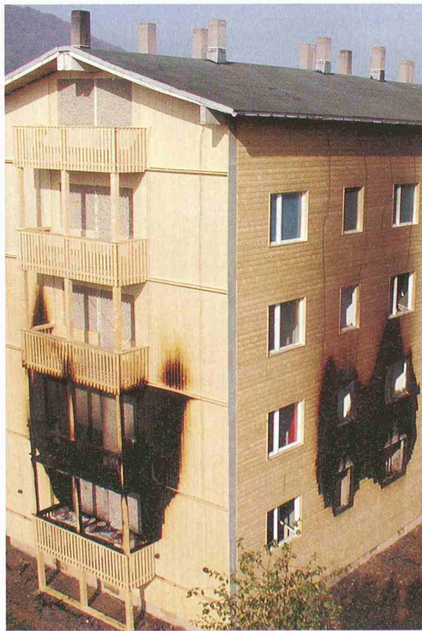
Konstruktive Brandschutzmassnahme bei mehrgeschossigen Holzbauten: Die Hinterlüftung wird in jedem Geschoss unterbrochen, so bleibt der Brand lokal begrenzt (Bild: Kotthoff / Lignum)
