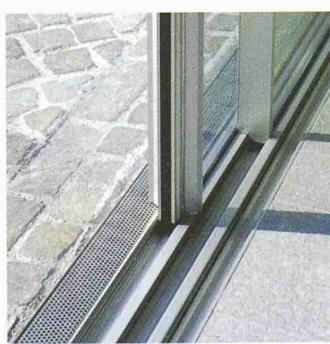
Rinne. Dank konsequenter Trennung von Innen- und Aussenschalen wird ein guter Rahmen-Isolationswert erreicht (U-Wert gerechnet 2.1 W/m<sup>2</sup>K). Aus der kleinen Rahmenfläche ergeben sich über das ganze Fenster gerechnet Spitzenwerte.
