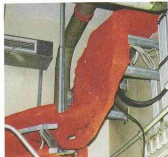
verhindert eine Brandausbreitung (z. B. durch einen Kurzschluss oder sonstigen Brandfall), verursacht keine Wartungskosten (nur bei Brandschäden austauschen) und keine Kabelreinigungsarbeiten. Das Produkt ist flexibel (kann überall an- und eingepasst werden), und die Kabel können jederzeit problemlos entfernt oder neu verlegt werden (die Montageklammer erlaubt häufiges Öffnen und
