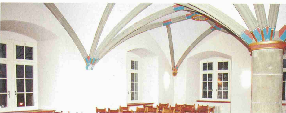
6 Mensa der Pädagogischen Hochschule in Rorschach mit schallabsorbierender Decke (Akustikputz mit Mineralfaser), 2003: Denkmalschutz und Akustikmassnahme in einem
