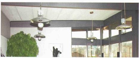
Moderner Wohnraum mit Akustikdecke aus mitteldichter Faserplatte (MDF, vorne geschlitzt und hinten gelocht); 2004
