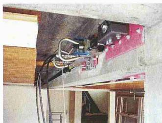
sichere Verankerung der Vorspannkraft und bietet gleichzeitig eine absolut flache Konstruktion. Sowohl im Gebrauchs- wie im Bruchzustand stellen sich folgende Verbesserungen des Tragverhaltens gegenüber traditionellen CFK-Lamellen ein: wesentlich reduzierte Durchbiegungen im Gebrauchs- zustand; positiv verändertes Rissbild und reduzierte Rissöffnungen, markant höhere Verstärkungswirkung und verbesserte Duktilität.
