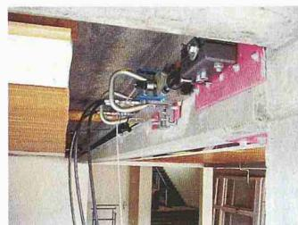
sichere Verankerung der Vorspannkraft und bietet gleichzeitig eine absolut flache Konstruktion. Sowohl im Gebrauchs- wie im Bruchzustand stellen sich folgende Verbesserungen des Tragverhaltens gegenüber traditionellen CFK-Lamellen ein: wesentlich reduzierte Durchbiegungen im Gebrauchs- zustand; positiv verändertes Rissbild und reduzierte Rissöffnungen, markant höhere Verstärkungswirkung und verbesserte Duktilität.
