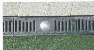
das integrierte Beleuchtungssystem wird die Entwässerungsrinne zum Gestaltungs- und Sicherheits-element. Markierung von Gefahrenzonen und unübersichtlichen Stellen wie Ausfahrten, Tunneleingängen oder Tramspuren sind einige Anwendungsbereiche. Trotz der Beleuchtung kann die Rinne mit hohen Lasten befahren werden. (Anmeldung und weitere Informationen siehe «Veranstaltungen» S. 46.)
