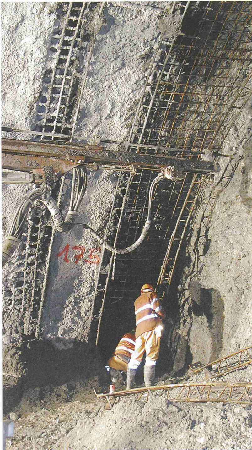
1 Bauablauf des 2001 für die Strecke im Verrucano-Rutschmaterial vorgesehenen Kalottenvortriebs mit Pilotstollen und Spiessen (Bilder: Basler & Hofmann)
