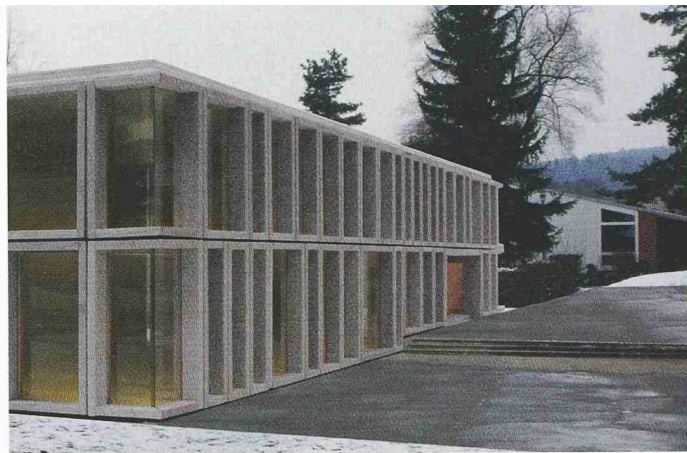
Fassade aus tragenden Betonrahmen
