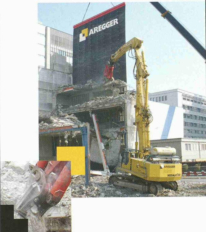
Abbruchobjekte sind meist verblüffend schnell zertrümmert. Die Erde bebt, Lärm und Staub sind infernalisch. Zurück bleibt ein Trümmerfeld, das in Tagen anstrengender und kostspieliger Kleinarbeit sortiert und für den Abtransport portioniert werden muss.
