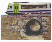
nicht zuletzt sind die Baukosten niedrig. Wellstahltunnels eignen sich für Fussgänger-, Radweg-, Verkehrs- und Wildtierunterführungen unter Bahntrassees und Schnellstrassen. Die Tunnels lassen sich mit Wellstahlelementen ausführen. Konstruktionsteile wie Böschungsschrägschnitte, horizontale Abbiegungen, Vertikalknicke, Abzweigungen, Öffnungen etc. können einfach in die Planung einbezogen werden. Sytec Bausysteme AG 3172 Niederwangen 031 980 14 14 | Fax 031 980 14 24
