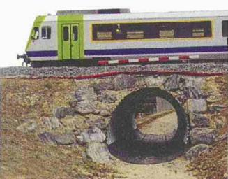
nicht zuletzt sind die Baukosten niedrig. Wellstahltunnels eignen sich für Fussgänger-, Radweg-, Verkehrs- und Wildtierunterführungen unter Bahntrassen und Schnellstrassen. Die Tunnels lassen sich mit Wellstahlelementen ausführen. Konstruktionsteile wie Böschungsschrägschnitte, horizontale Abbiegungen, Vertikalknicke, Abzweigungen, Öffnungen etc. können einfach in die Planung einbezogen werden.
