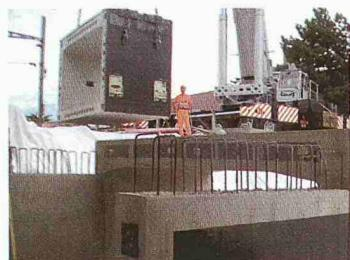
Die Abteilung Elementtechnik der Fanger AG hat sich auf die Herstellung, den Transport und die Montage von Unterführungen und Stützbauwerken spezialisiert. Die Firma hat bereits mehr als 100 Objekte dieser Trocken-Bauweise (Verlegung der Elemente auf ein
