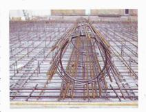
die genauen Armierungspläne. Gefertigt wird direkt auf der firmeneigenen Anlage, auf Rollbänder geschweisst wird Bamtec® auf die Baustelle geliefert. Die massgeschneiderten Armierungsteppiche werden nach einem einfachen Verlegeplan ausgerollt – schon kann betoniert werden. SFS Locher, 9435 Heerbrugg, 071 727 58 28, Fax 071 727 58 33, www.sfslocher.ch
