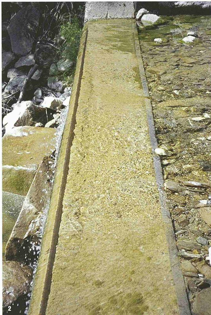
**Die durch Verschleiss von Beton im Wasserbau verursachten Kosten sind volkswirtschaftlich bedeutend. Vor diesem Hintergrund führt die TFB zusammen mit der VAW der ETH Zürich seit 1995 ein Forschungsprojekt über den Abrasionswiderstand von Beton durch. Abrasion ist als kombinierter Angriff von Wasser und Feststoffen (Geschiebe) auf Beton definiert. In Normen und Regelwerken wird auf diesen Aspekt zumeist nur am Rande und unvollständig eingegangen.**
