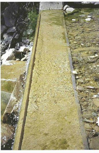
Die durch Verschleiss von Beton im Wasserbau verursachten Kosten sind volkswirtschaftlich bedeutend. Vor diesem Hintergrund führt die TFB zusammen mit der VAW der ETH Zürich seit 1995 ein Forschungsprojekt über den Abrasionswiderstand von Beton durch. Abrasion ist als kombinierter Angriff von Wasser und Feststoffen (Geschiebe) auf Beton definiert. In Normen und Regelwerken wird auf diesen Aspekt zumeist nur am Rande und unvollständig eingegangen.
