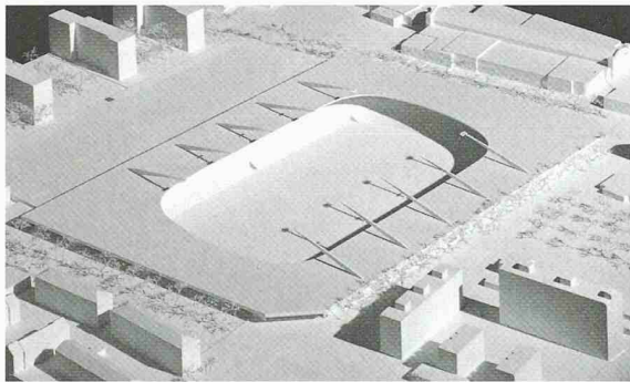
«Bescheiden in der Stadtlandschaft». Das Stadion ist in eine Gebäudemulde gesetzt. In einigen Bereichen genügen die Sichtanforderungen nicht, die Räume haben kein Tageslicht (Daniele Marques)
