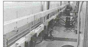
**LANZ HE-Stromschienen zur sicheren Stromübertragung und -Verteilung IP 68 Giessharzvergossen 400 A – 6000 A**
