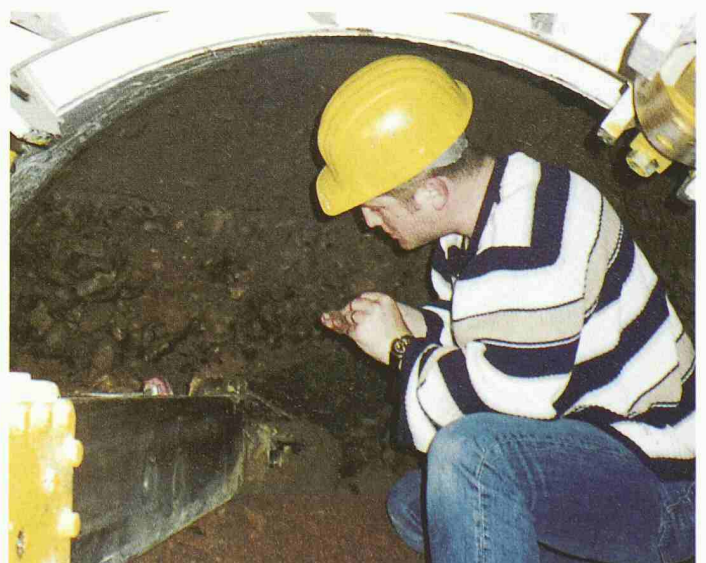
Ein Geologe prüft den Baugrund auf Standfestigkeit und Kontaminationen bei einem Pressvortrieb (Bild: Mader)
