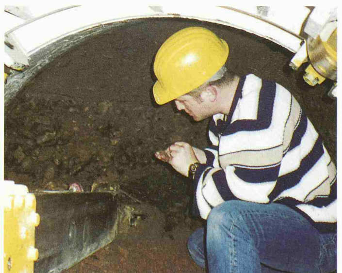
Ein Geologe prüft den Baugrund auf Standfestigkeit und Kontaminationen bei einem Pressvortrieb (Bild: Mader)
