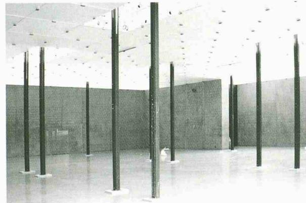
**Belastungsprobe für das Kunsthause Bregenz: «300 tons» von Santiago Sierra. Das Gewicht von 14 600 im obersten Geschoss zu Kuben gestapelten Betonsteinen wird in den Etagen darunter von Stützen abgetragen (Bilder: pd)**
