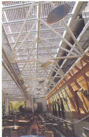
Migros-Restaurant Limmatplatz in Zürich: Dachverglasung mit Solarzellen sorgt für Licht- und Schattenspiel (Bild: Energiebüro)
