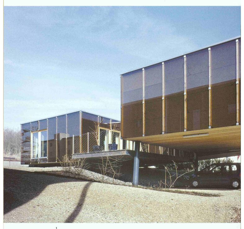
Hinter der Glasfassade hätte ursprünglich die Hanfdämmung sichtbar sein sollen. Nun ist eine Holzweichfaserplatte zwischen Glas und Dämmung integriert (Bild: Thomas Jantscher)
