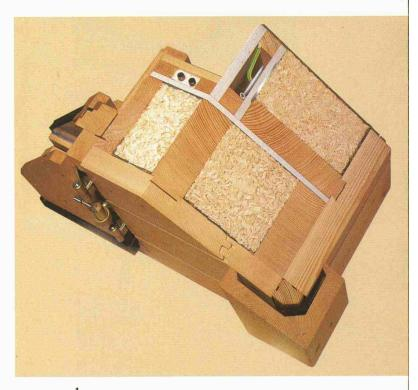
Dämmstoff aus nachwachsendem Rohstoff: Holzspäne «Hoiz S45» in den Zwischenräumen der Gebäudehülle (Detail von Fenster und Wandecke; Bild: Baufritz)
