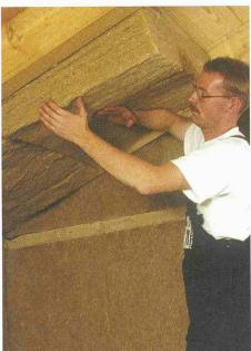
2 «Thermohanf»-Dämmmatten wurden im Haus Nigg eingesetzt (siehe folgenden Artikel; Bild: Hock und Stroba)
