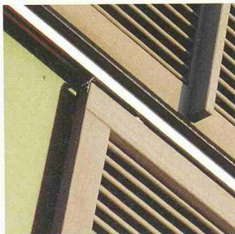
die spielfreie Lauf- und Führungstechnik garantieren Laufruhe und hohe Verschleissfestigkeit. Schienenpuffer und Rückhaltefedern sorgen für die gewünschte Stabilität. Für die manuelle Version ist auf Wunsch eine automatisch einrastende Arretierung erhältlich, die vollständig in den Schiebemechanismus integriert ist. Die manuelle Version lässt sich zu einem späteren Zeitpunkt mit denselben Systemkomponenten auf Automatik umrüsten.
