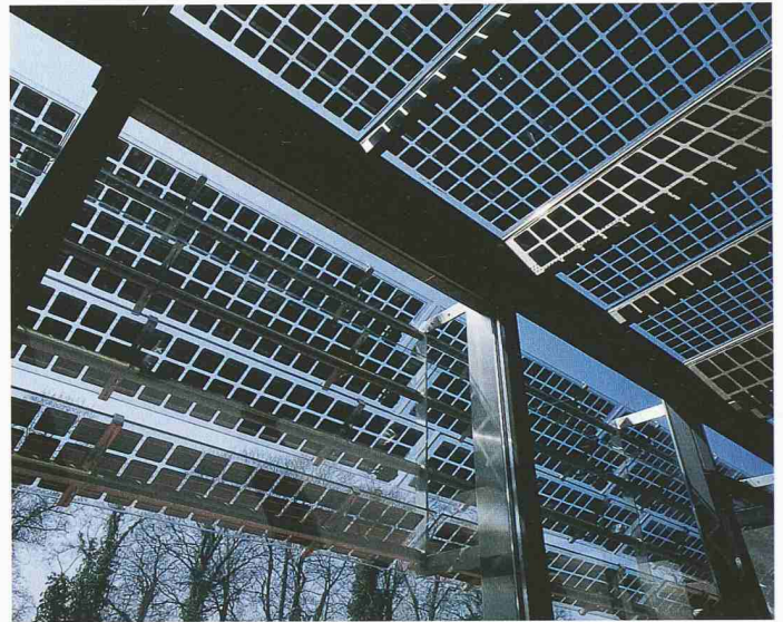
Kollektoren als Energiespender und Sonnenschutz an der Sporthalle der Kantonsschule Stadelhofen, Zürich (Bild: Reinhart Zimmermann)
