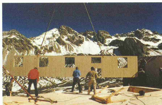
Montage eines langen Wandstückes. Die Fensteröffnungen können unabhängig von einem Raster frei angeordnet werden (Bild: Schilliger)
