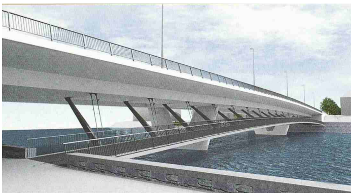
Blick unter die Hauptbrücke und auf den angehängten Fussgängersteg. Dieser verbindet die tiefer liegenden Uferwege (1. Rang, Projekt Quadral, Bänziger + Bacchetta + Fehlmann)
