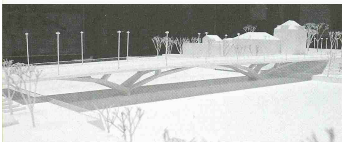
Tragstruktur, die die Kräfte bündelt und nachvollziehbar ableitet (2. Rang, Projekt Transparenz, IUB Ingenieure)
