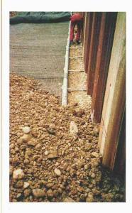
Für die Verbreiterung der bestehenden Brücke Birchstrasse beim Bahnhof Seebach in Zürich wurde eine mit Geogittern rückverankerte Spundwand mit vorgehängter Betonverkleidung erstellt. Auf Grund der engen Platzverhältnisse und aus Zeitgründen kam eine Schwergewichtsmauer nicht in Frage.
