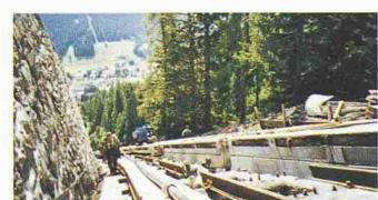
**12 Neue Höchstleistungen auf alten Mauern** | *Urs Schaufelberger* | Der neue, leistungsfähige «Parsenn Railblitz» in Davos rollt weiterhin auf dem Unterbau und den Viadukten der altehrwürdigen 70-jährigen Standseilbahn. Das neue Leben der alten Mauern beruht auf einer Fitnesskur mit vorgefertigten Bauteilen, selbstverdichtendem Beton und einem unkonventionellen Bauablauf.
