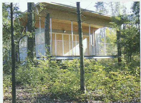
Waldhütte Elsau, Zehnder + Kuhn Architekten, Winterthur. Die Waldhütte «schwebt» über dem Boden, die Stützen gründen auf Punktfundamenten – der Waldboden bleibt möglichst unberührt. Das Dach ist begrünt, zum Heizen im Winter genügt ein Zimmerofen (Bild: Zehnder + Kuhn)
