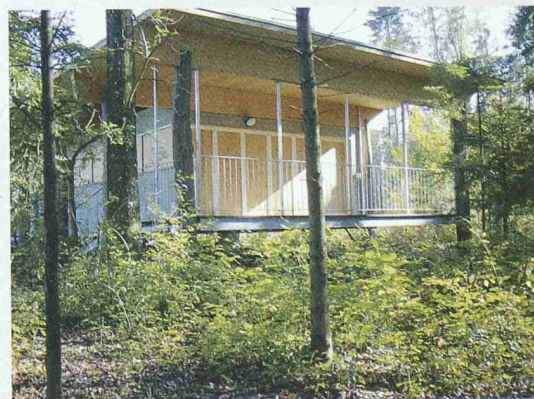
Waldhütte Elsau, Zehnder + Kuhn Architekten, Winterthur. Die Waldhütte «schwebt» über dem Boden, die Stützen gründen auf Punktfundamenten – der Waldboden bleibt möglichst unberührt. Das Dach ist begrünt, zum Heizen im Winter genügt ein Zimmerofen (Bild: Zehnder + Kuhn)
