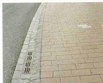
Die SLR-V-Rinne der Poly Bauelemente AG ist ausgesprochen schmal konstruiert (Einbaubreite 15 cm) und ragt deshalb, zwischen Rinnstein und Asphalt eingebaut, nicht in die Radspur hinein. Gefährliche Ausweichmanöver von Zweiradfahrern, verursacht durch in die Fahrbahn reichende Schachtabdeckungen oder durch abgesenkte Entwässerungsschächte, können damit unterbunden werden. Gerät ein Rad auf die Rinnenabdeckung, verhindern die gebogenen Rost-Längsschlitzte ein Ausrutschen.
