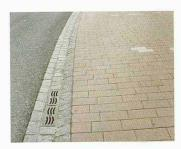
Die SLR-V-Rinne der Poly Bauelemente AG ist ausgesprochen schmal konstruiert (Einbaubreite 15 cm) und ragt deshalb, zwischen Rinnstein und Asphalt eingebaut, nicht in die Radspur hinein. Gefährliche Ausweichmanöver von Zweiradfahrern, verursacht durch in die Fahrbahn reichende Schachtabdeckungen oder durch abgesenkte Entwässerungsschächte, können damit unterbunden werden. Gerät ein Rad auf die Rinnenabdeckung, verhindern die gebogenen Rost-Längsschlitze ein Ausrutschen.
