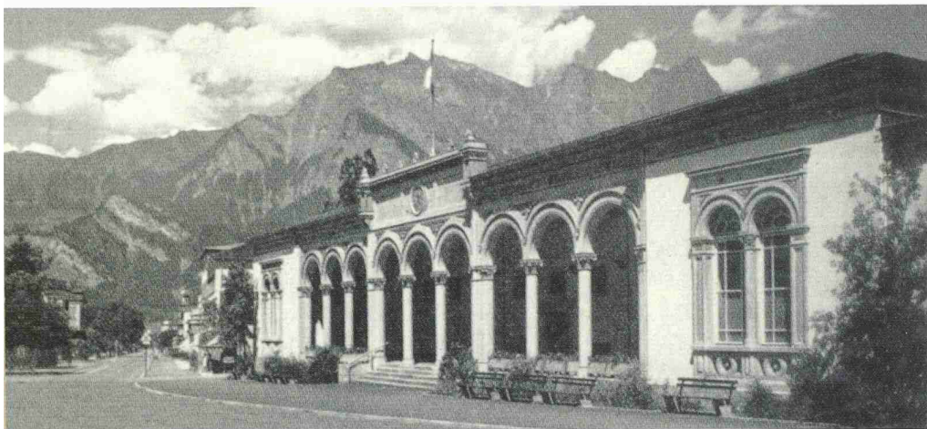
Das 1868 erbaute Dorfbad in Bad Ragaz (SG), ein wichtiger Zeuge der Entwicklung des Bädertourismus, wird saniert und umgenutzt. Der klassizistische Bau wird künftig das Tourismusbüro und Ausstellungsräume aufnehmen – die Badewannen bleiben leer (Bild: Kunstdenkmäler Kt. SG)
