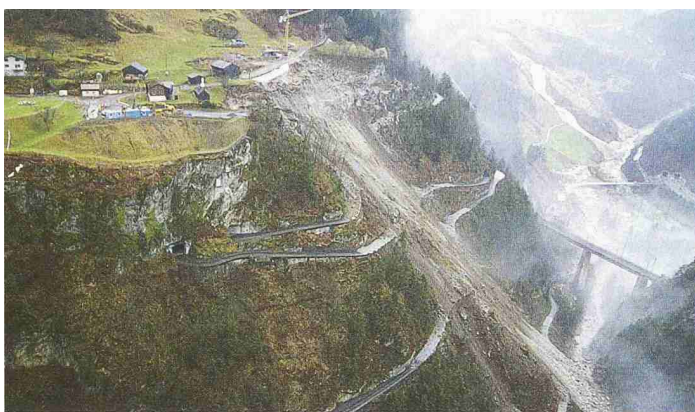
Die Bristenstrasse nach der Sprengung am 31. März 2003. Fünf Strassenabschnitte waren mit einem stossdämpfenden Schotterbett vorbereitet worden. Unerwartet rutschten aber ganze Abschnitte ab (Bild: ZvG)
