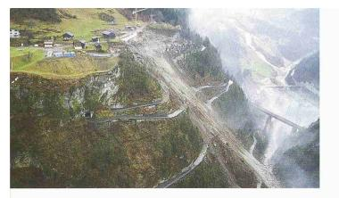
Die Bristenstrasse nach der Sprengung am 31. März 2003. Fünf Strassenabschnitte waren mit einem stossdämpfenden Schotterbett vorbereitet worden. Unerwartet rutschten aber ganze Abschnitte ab (Bild: ZvG)
