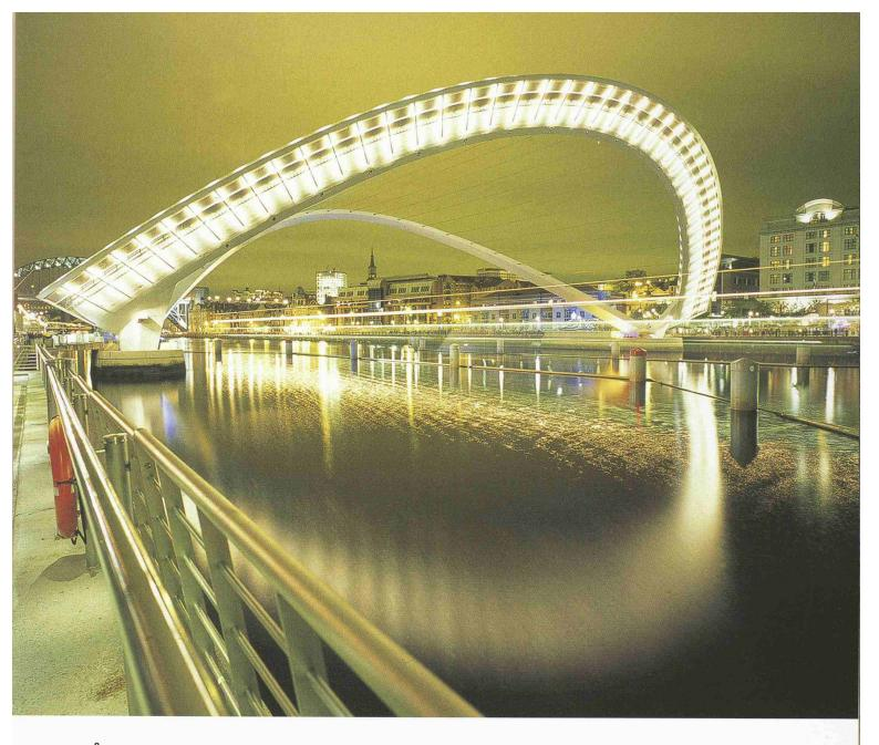
3 Die aufgeklappte Brücke. Der Tragbogen und (mit beleuchteter Untersicht) die Fahrbahn für Fussgänger und Radfahrer halten sich mit Hilfe von Spannkabeln die Waage (Bild: Gifford and Partners)
