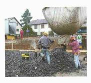
Magerbetonschicht, die beim Einsatz von plattenförmigen Dämmstoffen erforderlich sind.
