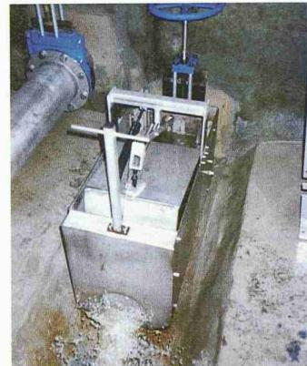
schlossenen klärtechnischen Einrichtungen durch die anfallenden erheblichen Wassermengen nicht zu überlasten, ist bei Regenstausystemen der Einbau von Drosselinrichtungen notwendig. Roshard liefert dazu Abflussbegrenzer, die auf sichere Weise für konstante Abflussmengen sorgen.
