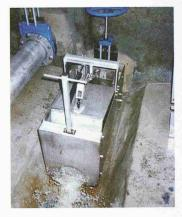
schlossenen klärtechnischen Einrichtungen durch die anfallenden erheblichen Wassermengen nicht zu überlasten, ist bei Regenstausystemen der Einbau von Drosseleinrichtungen notwendig. Roshard liefert dazu Abflussbegrenzer, die auf sichere Weise für konstante Abflussmengen sorgen.
