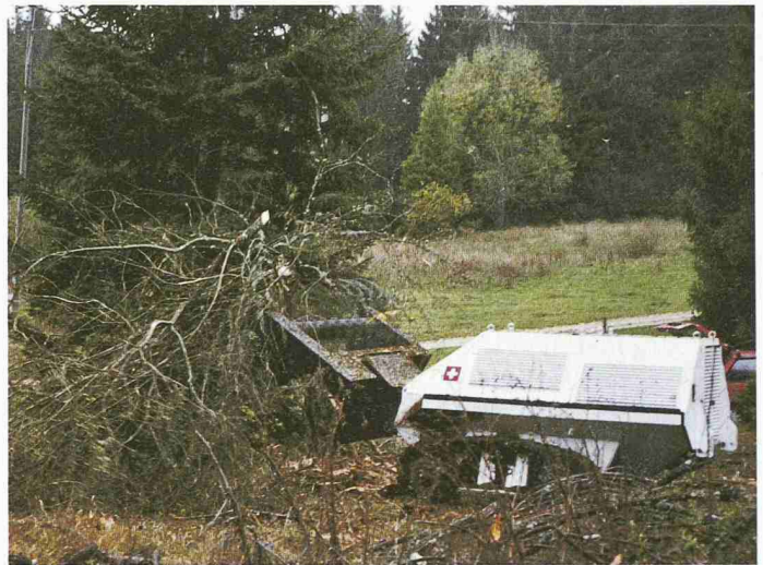
Der ferngesteuerte Digger räumt mit seinen Kettenpeitschen Strauchwerk weg und bringt Minen zur Explosion (Bilder: pps)
