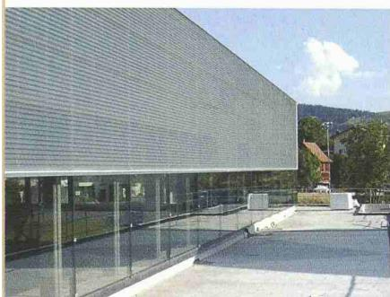
aus Wellplatte und Profil (beides aus GFK). Bei der Montage wird das Profil auf die Unterkonstruktion montiert, maximal alle 1000 mm sind Verschraubungen erforderlich. Zwischen Fassadenverkleidung und Profil wird ein Gummidichtungsprofil als Schutz vor Kondensaten eingelegt. Die Wellplatten werden horizontal um eine Wellung überlappt. GFK ist UV-, feuer- und witterungsbeständig und hat eine Lebensdauer zwischen 30 und 60 Jahren.
