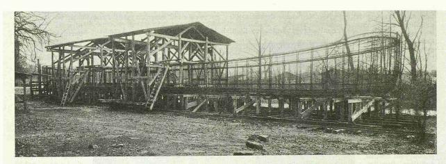
Abb. 4. Armierung und Betonierungsgerüst des Eisenbeton-Schleppkahns nach "System Züblin-Koller", ausgeführt von Ed. Züblin & Cie., Strassburg.
