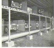
Bild 3. Untere und obere Boxenreihe sowie Mittelteil-Traggerüst mi Wagenentnahmepforte (Schiebebühne fehlt)
