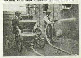
Abb. 3. Verputzen einer Gebäude-Fassade mittels der Zementkanone; Handregulierung des durch den dünnen Schlauch zugeführten Anmachwassers
