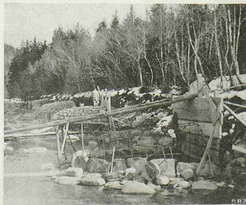
Abb. 14. Armieren und Verkleiden von Schildkröten
