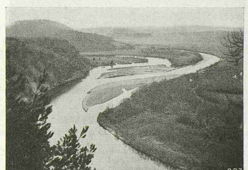
Abb. 2. Saanemündung nach Ausführung von 150 m Wolf'scher Wand, 1931
