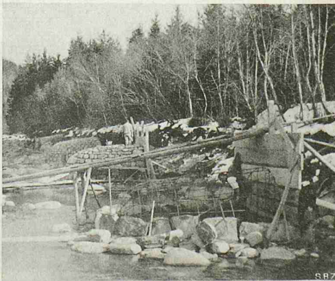
Abb. 14. Armieren und Verkleiden von Schildkröten
