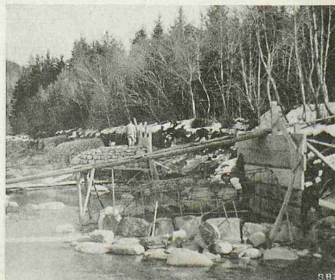
Abb. 14. Armieren und Verkleiden von Schildkröten
