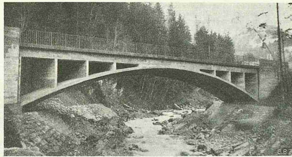
Abb. 3. Spitalbrücke über die Engstligen; Staatstrasse Frutigen-Adelboden.
