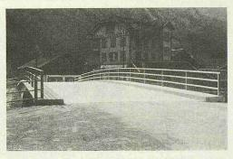
Abb. 7. Betonfahrbahn und geschweisste Profileisen-Geländer.
