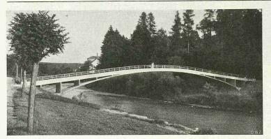
Abb. 1. Fussgängersteg über die Töss bei Wülflingen. Spannweite rd. 40 m, Bauzeit 2 Monate.
