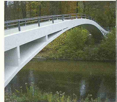
Die 2004 renovierte Mailart-Brücke in Winterthur Wülflingen (Bild: de/Red.)
