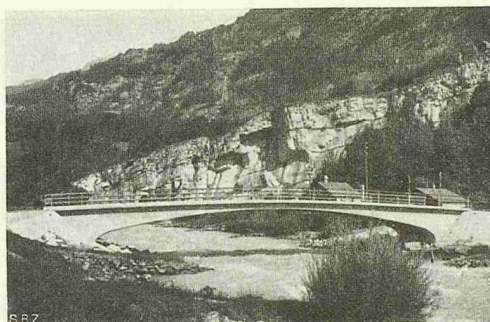
Abb. 6. Aarebrücke der Grimselstrasse in Innertkirchen.
