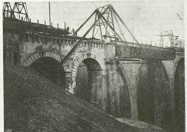
Abb. 3. Abbruch des letzten, rechtsufrigen Ueberbaues; Verankerung im Mauerwerk des Viadukts.
