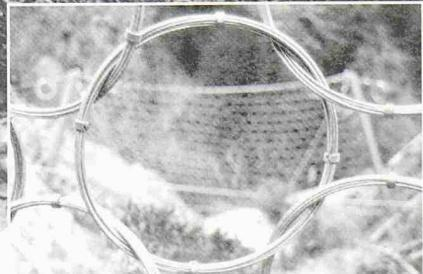
Geröllmaterial von bis zu 1'000 m<sup>3</sup> kann durch flexible ROCCO® Ringnetz-Barrieren gestoppt werden. Ihre leichte Bauweise erlaubt eine einfache und kostengünstige Installation. Die filigranen Ringnetz-Barrieren, bemessen für dynamische Aufschläge, sind eine echte Alternative zu massiven Beton- und Stahlbauten.
