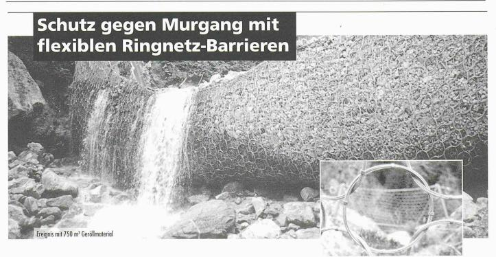
Geröllmaterial von bis zu 1'000 m³ kann durch flexible ROCCO® Ringnetz-Barrieren gestoppt werden. Ihre leichte Bauweise erlaubt eine einfache und kostengünstige Installation. Die filigranen Ringnetz-Barrieren, bemessen für dynamische Aufschläge, sind eine echte Alternative zu massiven Beton- und Stahlbauten.
