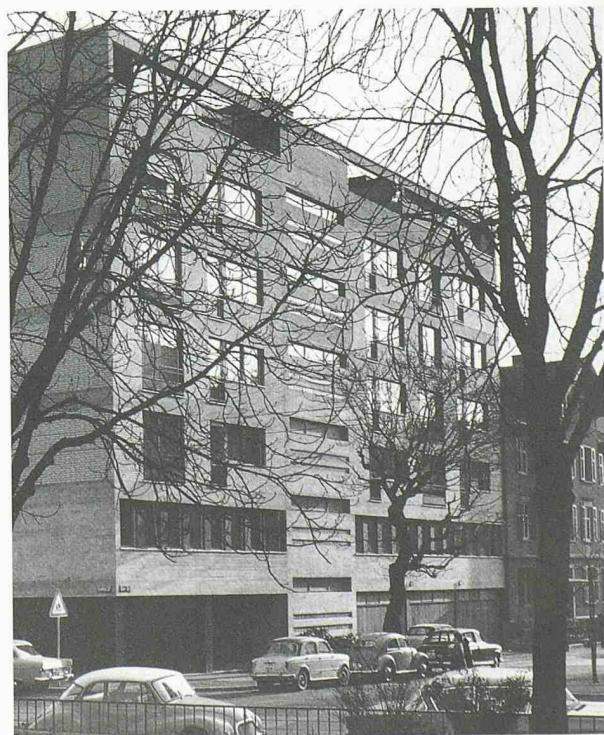
In dem Wohn- und Geschäftshaus im Seefeld, das er in den Jahren 1957–60 baute, befand sich auch sein Büro. Heute lebt Jakob Zweifel in dem Gebäude (Bilder: rhs/red., «Nachkriegsmoderne Schweiz», Basel, Boston, Berlin 2001)
