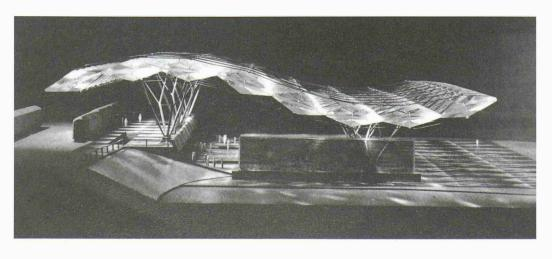
Der erste Entwurf für das Dach des Expo-Bahnhofs 1964 sah verglaste, innen beleuchtete Rhomboiden vor, die in ein sinusförmiges Grossfachwerk eingebaut worden wären (Bild aus: Pierre Zoelly: Elemente einer Architektursprache, Basel/Boston/Berlin 1998)
