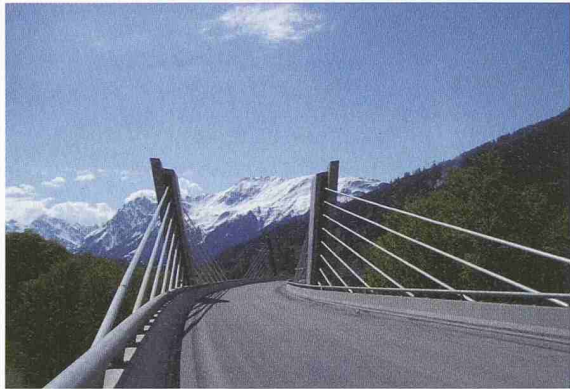
Die Sunnibergbrücke Klosters, ein beispielhaftes Werk von Christian Menn, dipl. Bau-Ing. ETH/SIA (Bild: fbh)
