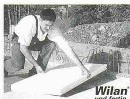
Isolationselemente **einseitig** belegt mit äußerst widerstandsfähigen Fertigdeckschichten aus Kunststoffen, Faserzement oder Holzwerkstoffplatten. Für das direkte Einlegen und einbetonieren in Deckenschalungen oder für nachträgliche Montagen.
