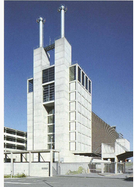
Antoniol + Huber + Partner: Kathedrale des Abfalls. Kehrichtverbrennungsanlage Weinfelden (TG), 1998/99 (Bild: Falk von Trautenberg)
