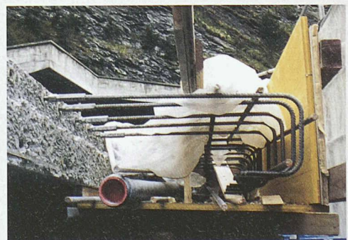
Instandsetzung 1998/99 der Viamala-Brücke, A 13 Chur–San Bernardino–Bellinzona; Ersatz der Konsolköpfe (Bild: ar/red.)
