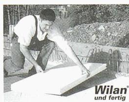
Isolationselemente einseitig belegt mit äusserst widerstandsfähigen Fertigdeckelschichten aus Kunststoffen, Faserzement oder Holzwerkstoffplatten. Für das direkte Einlegen und einbetonieren in Deckenschalungen oder für nachträgliche Montagen.
