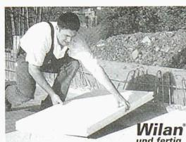
Isolationselemente einseitig belegt mit äusserst widerstandsfähigen Fertigdeckschichten aus Kunststoffen, Faserzement oder Holzwerkstoffplatten. Für das direkte Einlegen und einbetonen in Deckenschalungen oder für nachträgliche Montagen.
