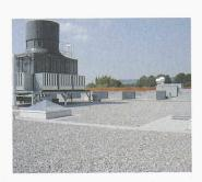
Flachdächer funktionieren – richtig konzipiert – jahrzehntelang. Das rund 3500 m<sup>2</sup> grosse Flachdach des Neubaus der Sauber Aerodynamik AG in Hinwil wurde in drei Etappen ausgeführt. Die Dachunterkonstruktion besteht aus Beton und zu einem kleineren Teil aus Profilblech. Die unterschiedliche Temperatur-Dehnung ist mit einer flexiblen Kunststoff-Dachbahn einfach überbrückbar.
