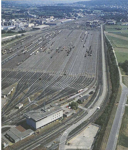
Der Rangierbahnhof Spreitenbach wird ausgebaut (Bild: Comet)
