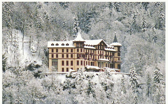
Gäste dank Geschichte: Im originalen Zustand erhaltene Hotels haben heute mehr Erfolg als andere. Das Hotel Giessbach am Brienzensee ist Historisches Hotel des Jahres 2004 (Bild: Keystone / Jürg Müller)
